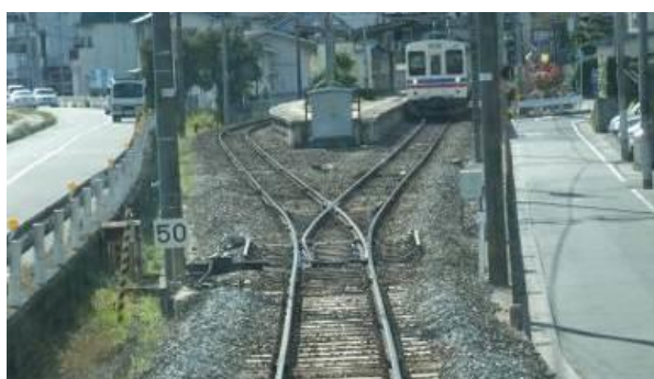
図-48 行き違い設備の例（三滝駅）
